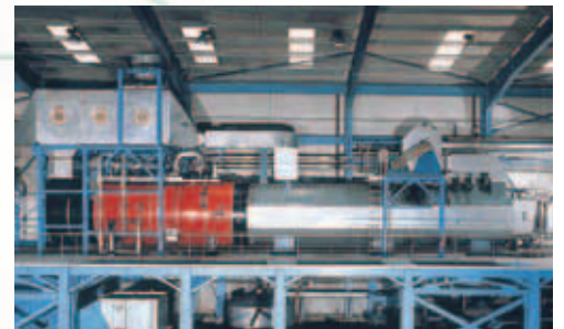
Industria rendering • Combustore con recupero calore per produzione vapore
