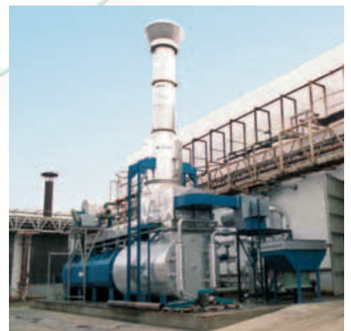
Industria rendering • Combustore con recupero calore in olio diatermico
