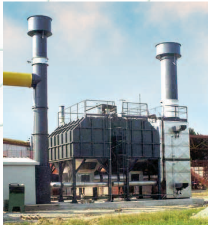
Vulcanizzazione gomma • 30.000 Nm 3 /h
