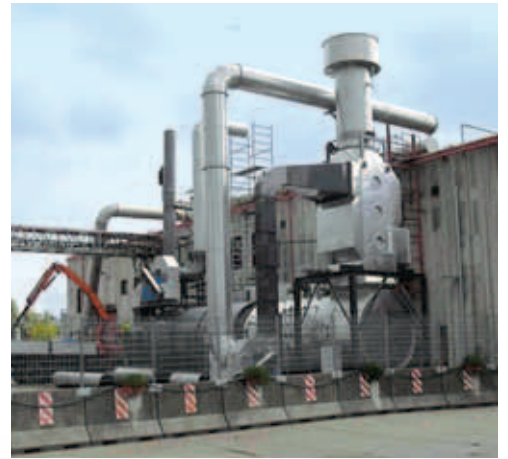
Industria rendering Combustore con recupero calore per produzione vapore
