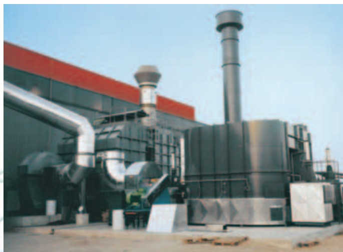
Trattamenti superficiali coils • n. 2 combustori rigenerativi da 45.000 Nm 3 /h installati in tempi diversi
