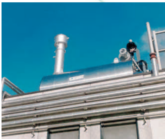
Friggitura • Combustore recuperativo
